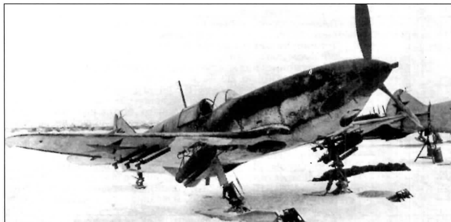
ЛаГГ-3 23-й серии. Под крылом направляющие под РС-82 и зажигательные приборы ЗАП-6 ЛаГГ-3 of 23th series. Start devices for РС-82 unguided missiles and ignition apparatus ЗАП-6 are under the wing
