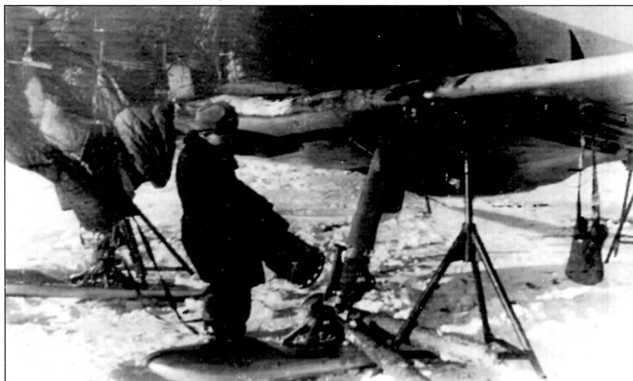
Техник прогревает опору лыжного шасси Technician is warming up ski landing gear
